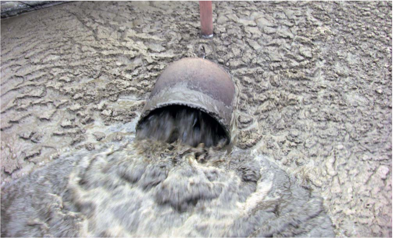
Рис. 3. САМОДЕЛЬНЫЙ АЭРАТОР
