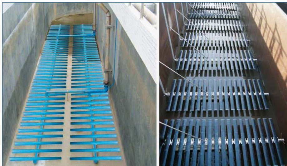
■ Рис. 4. Варианты комплектации аэротенков мембранными пластинчатыми аэраторами «алюминиевый борд», материалы: силикон, EPDM
