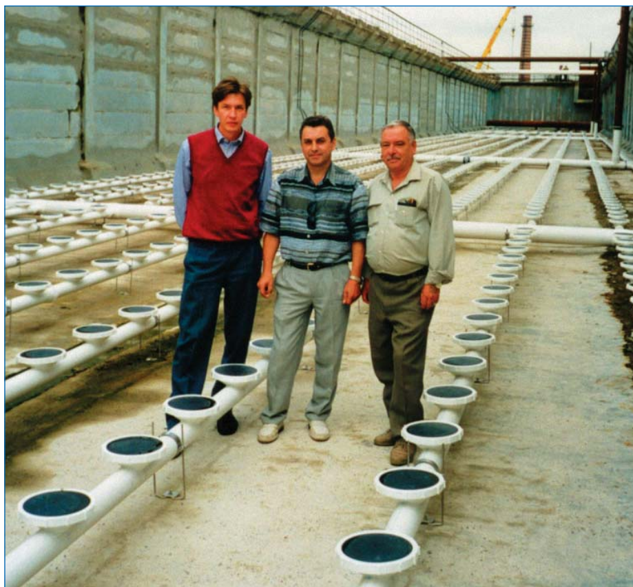
■ Рис. 2. Сдвоенный мембранный дисковый аэратор фирмы Siemens Water Technologies (Германия) - слева. Мембранный диффузор фирмы ABS Nopon (Финляндия) для контактного процесса SBR с периодической аэрацией
